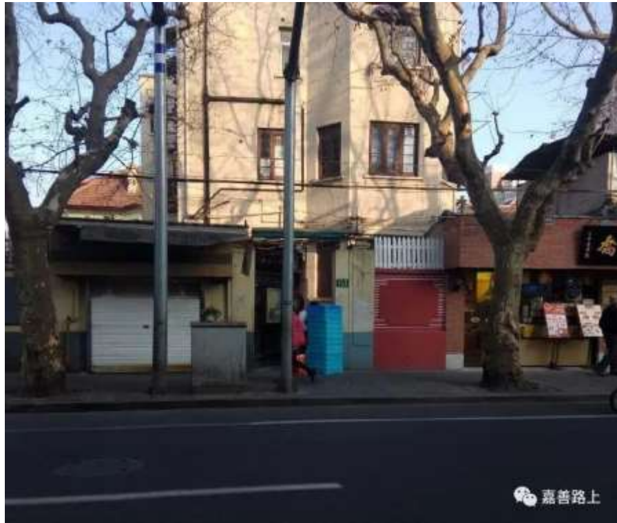
313 号天启医院小楼
