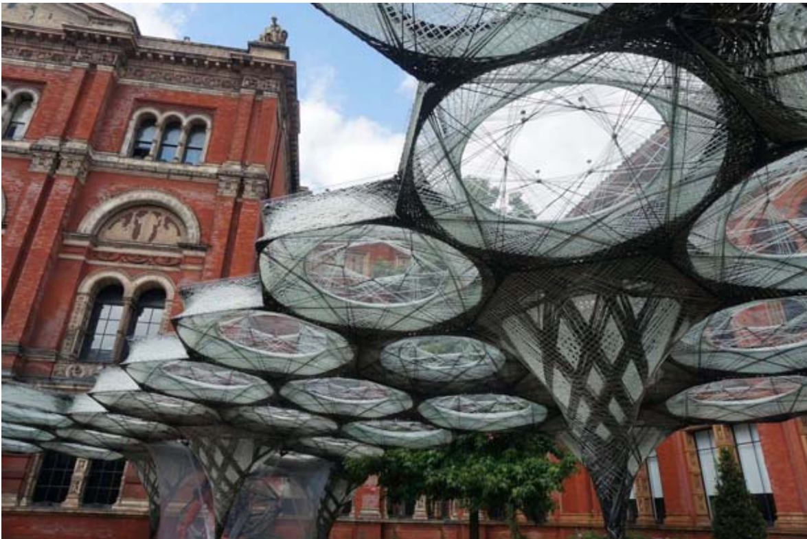
正在建造中的用人造纤维长丝作为建材的现代化的艺术凉亭，由德国斯图加特大学的工程师发明设计。照片左下方桔红色的就是编织机器。
